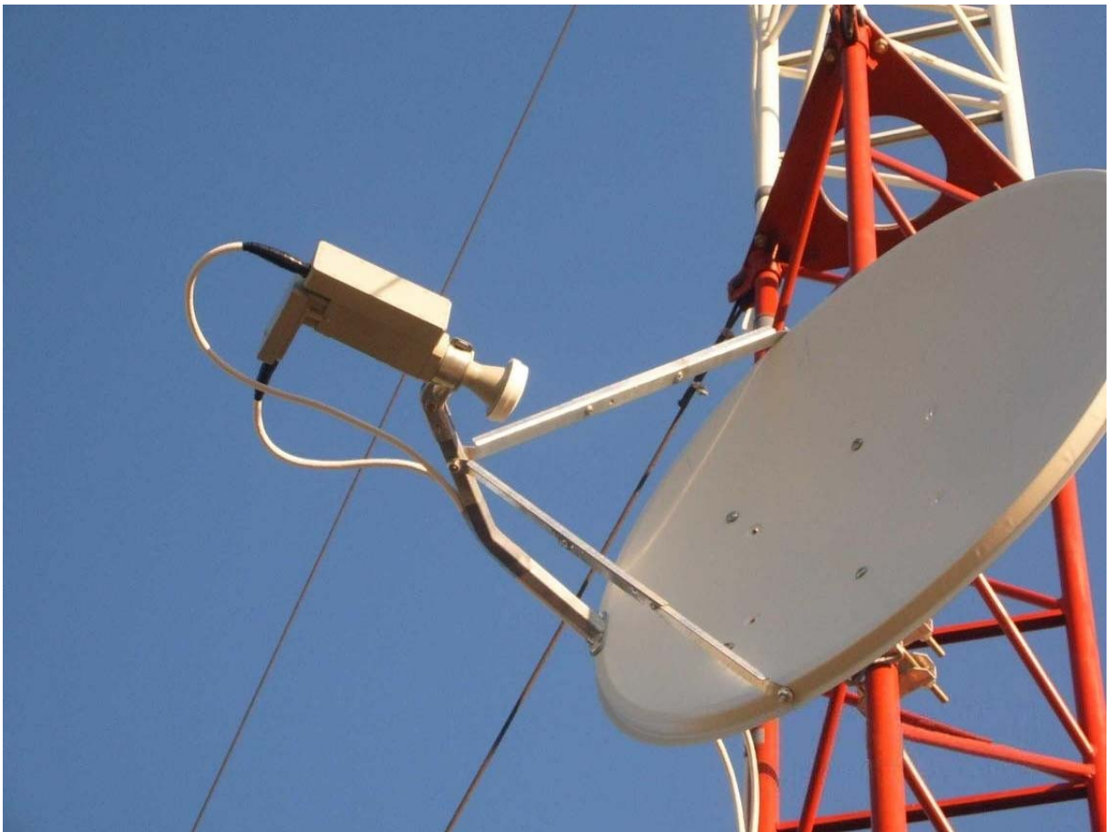
Рис. 4 и 5. Пример типового монтажа офсетного рефлектора 0,6 м. Вид спереди и сзади. Модуль СВЧ закреплен в фокусе рефлектора горизонтально.
