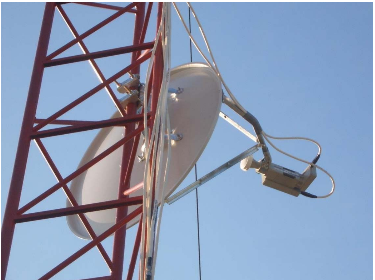
Рис. 4 и 5. Пример типового монтажа офсетного рефлектора 0,6 м. Вид спереди и сзади. Модуль СВЧ закреплен в фокусе рефлектора горизонтально.
