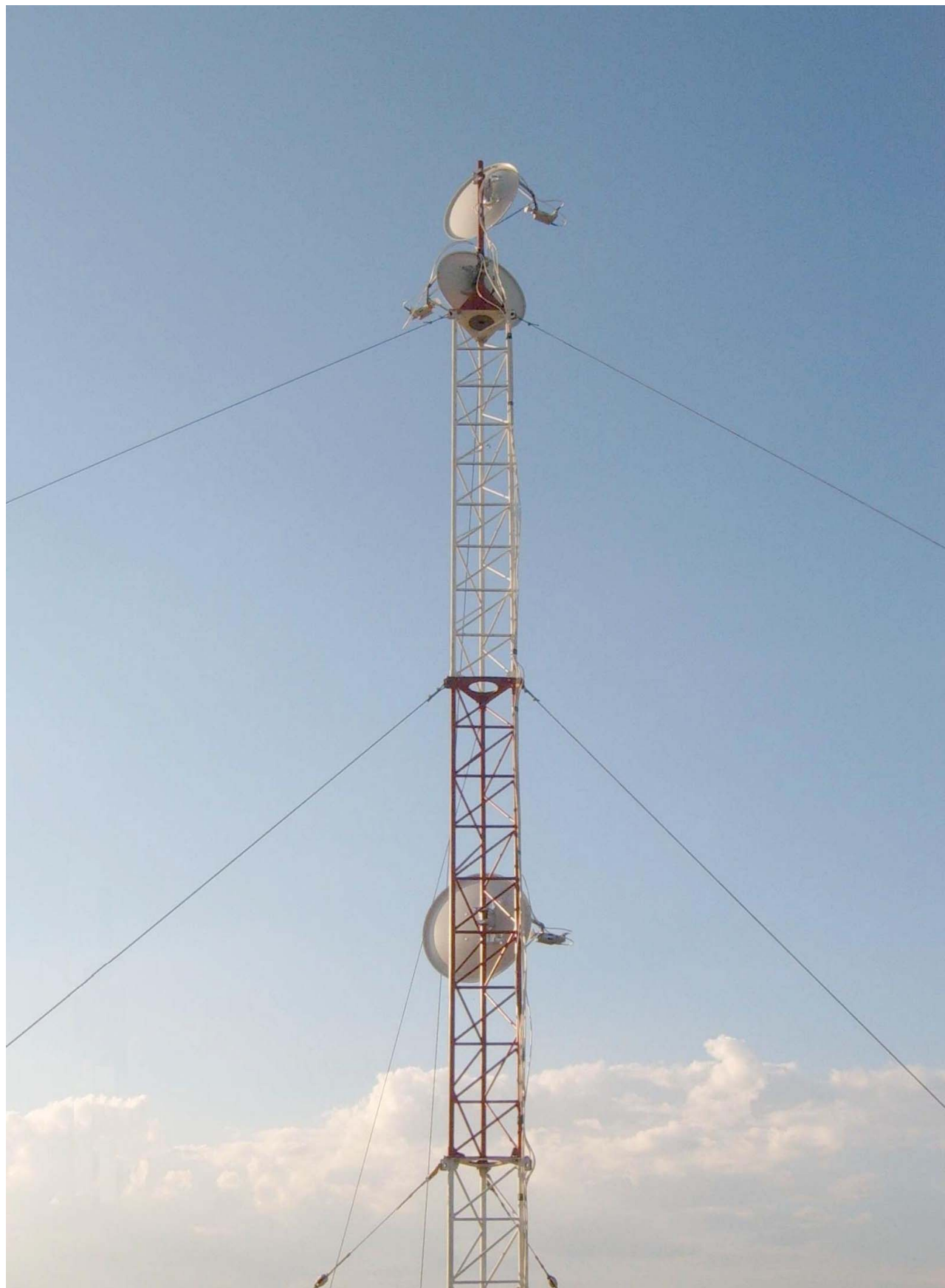
Рисунок 1. Монтаж нескольких рефлекторов 0,6 м различных радиотрактов на одной мачте.
