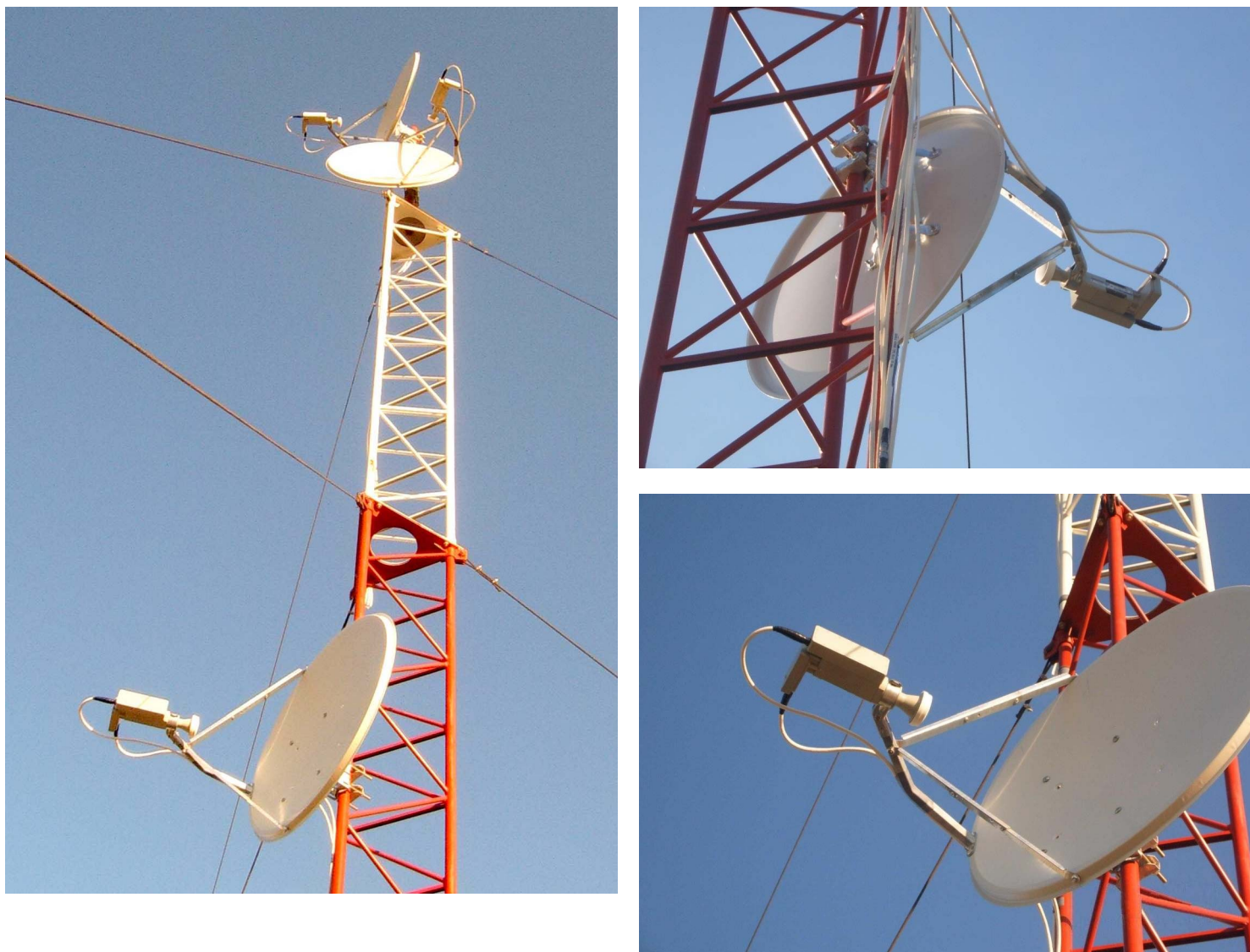
Рисунок 2. Общий вид оборудования наружного размещения - открытого офсетного рефлектора диаметром 0,6 м с закрепленным в его фокусе модулем СВЧ с рупорной антенной.
